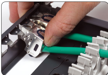
11. Konnektor klipses i panelet.
