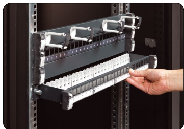
13. Patchpanelet kan nu skubbes på plads igen.
